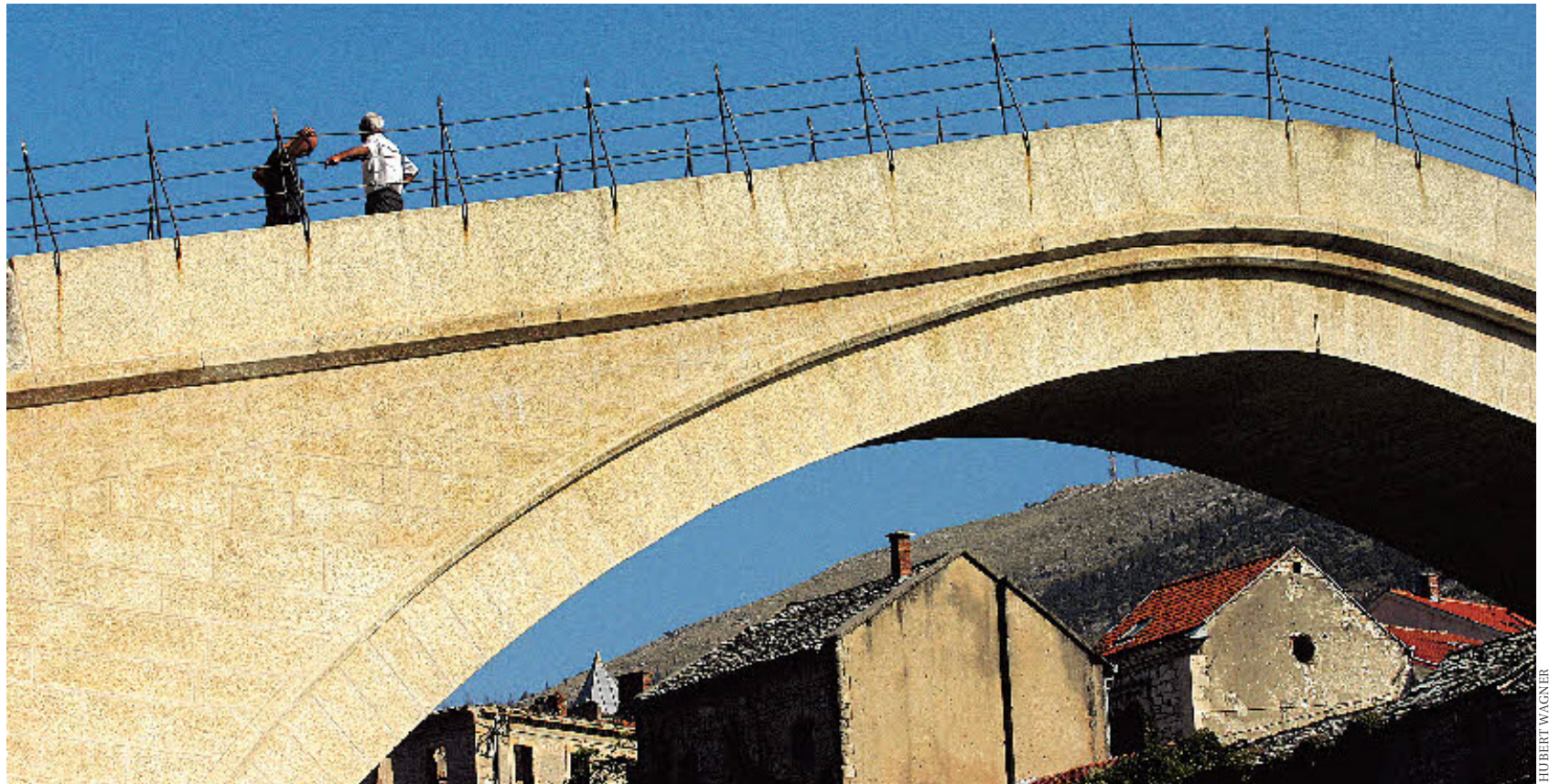
Mostars Wahrzeichen, die „Alte Brücke“ (Stari Most) über die Neretva, 1993 von kroatischen Soldaten zerstört, 2004 wiederaufgebaut – darunter im Bosnien-Krieg zerstörte Häuser Ost-Mostars
